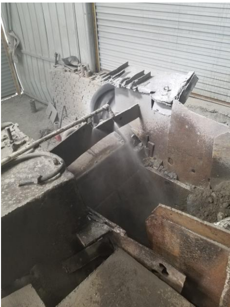
一破入口水雾喷淋降尘
