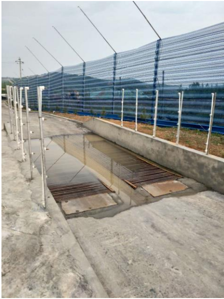
厂区出入库洗车台
