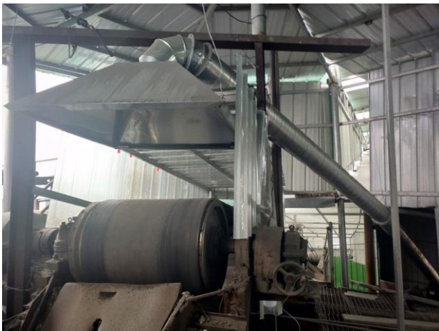
筛分集气罩+集气管道
