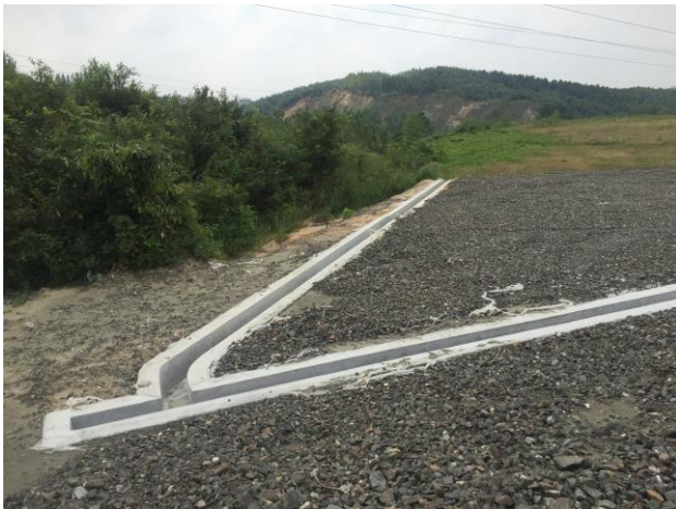
尾矿库截洪沟
