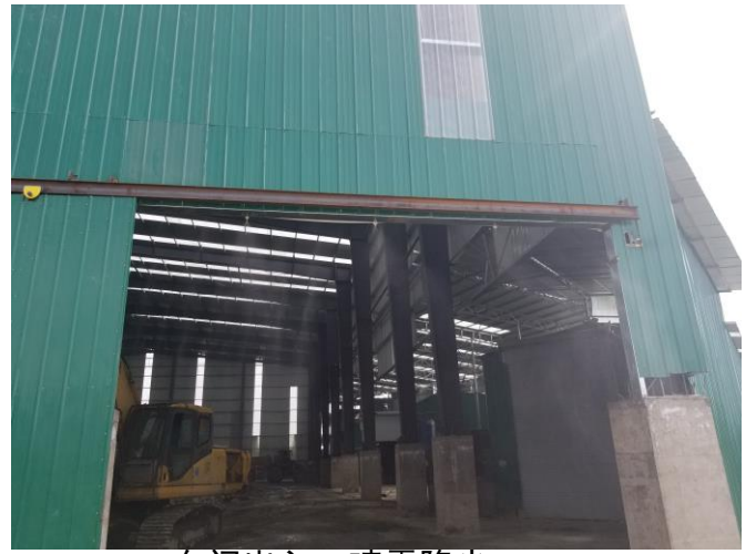
车间出入口喷雾降尘
